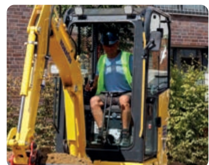
Große Glasflächen sorgen für eine exzellente Rundumsicht auf der Baustelle
